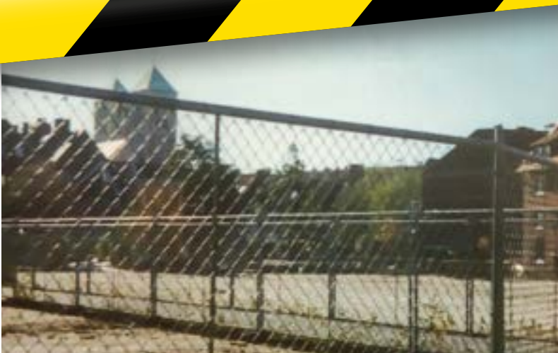
10.000 m 2 großes Baugelände
