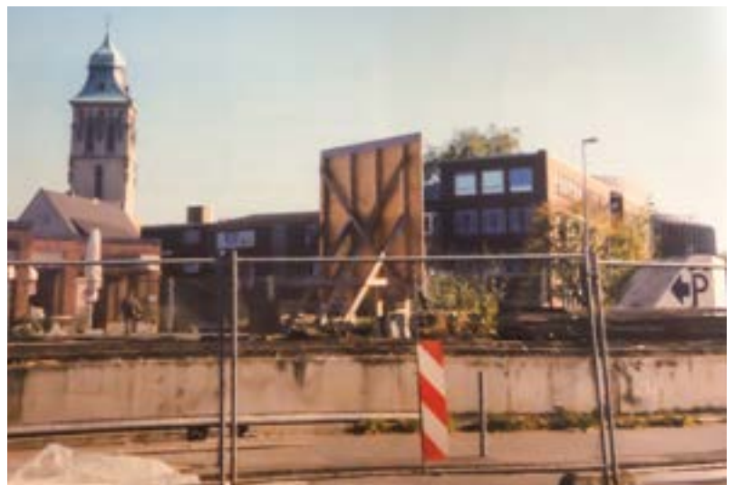
Hier wird später Haus 5 stehen
